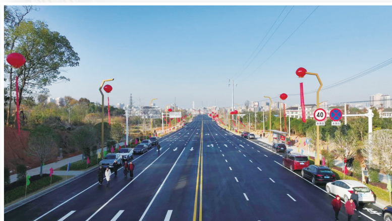
12月22日,中伟大道正式竣工通车。 张平华 摄
