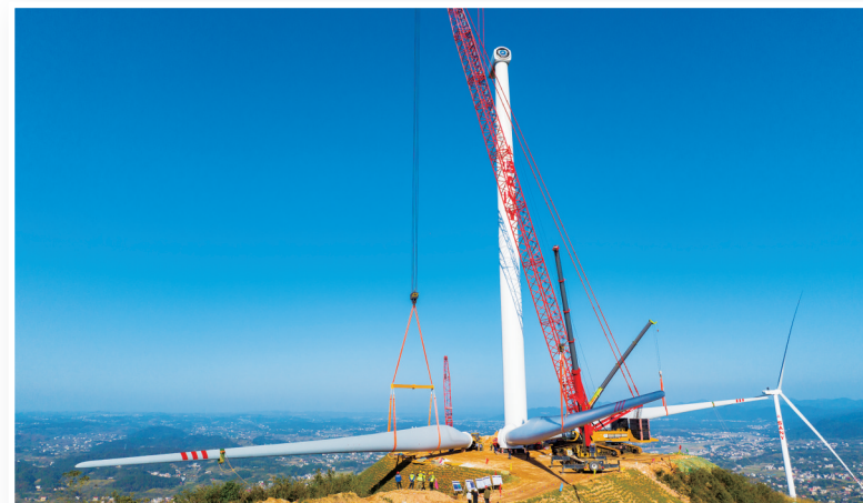
邵东皇帝岭风电场施工现场。 刘海 摄
