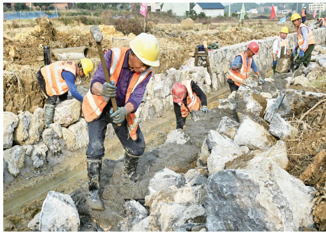
11月5日,施工人员在洞口县竹市镇梓木村修建农田灌溉渠道。入秋以来,该县加大中小型水库除险加固、河道治理、高效节水灌溉工程等水利基础设施建设,为来年农业生产和防汛抗旱夯实基础。
