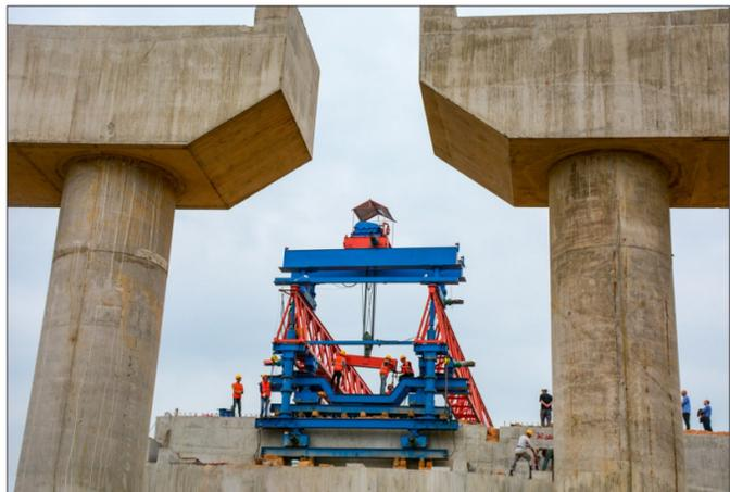
11月3日,施工人员在邵阳县金石镇金夷村新新高速公路二标段高架桥头调试首片箱梁。当日,该标段率先开展架箱梁作业。邵阳日报通讯员 郑国华 邓喧喧 摄影报道
