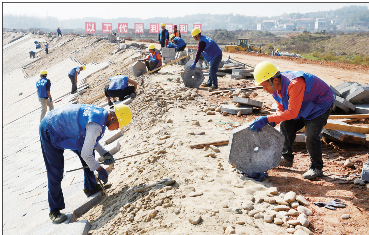
犬木塘水库建设工程为衡邵干早走廊头号工程,是省实施以工代赈的重点项目,总投资102.7亿元。该项目的龙湾岭抬填区建设完成后,新增机耕道4260米,新增高标准排灌渠3120米,预计吸纳易地搬迁等低收入群体务工207人,发放劳务报酬228万元,以此促进当地群众就地就近就业增收。图为11月2日,附近群众在龙湾岭抬填区以工代赈项目工作。邵阳日报记者 申兴刚 摄影
