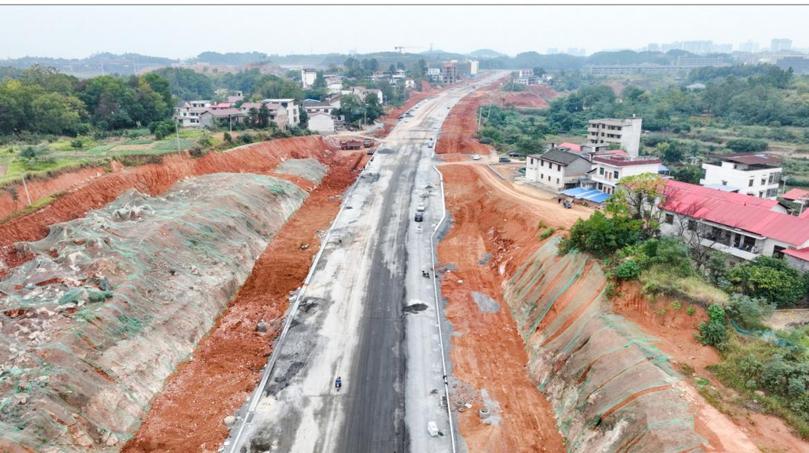
北塔路起于资江北路,止于中山路,全长4147米,为城市主干道。目前,该项目已完成土路基工程、排水工程、挡土墙、水稳工程、路侧石工程,预计11月底实现通车。该道路建成后,将加快北塔区与新邵县城的连接,基本解决我市北大门的过境交通等问题,极大补充市区交通路网建设。邵阳日报记者 伍浩 通讯员 刘恩权 摄影报道
