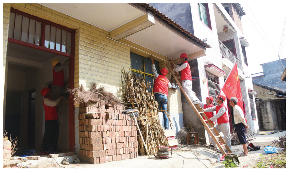
▲塘渡口供电所员工帮助村民整改低压线路。
