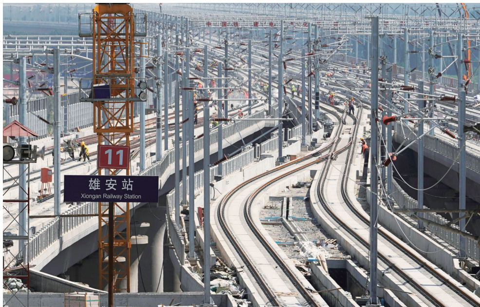
7月24日,工人在京雄城际铁路雄安站施工。新华社记者 邢广利 摄
