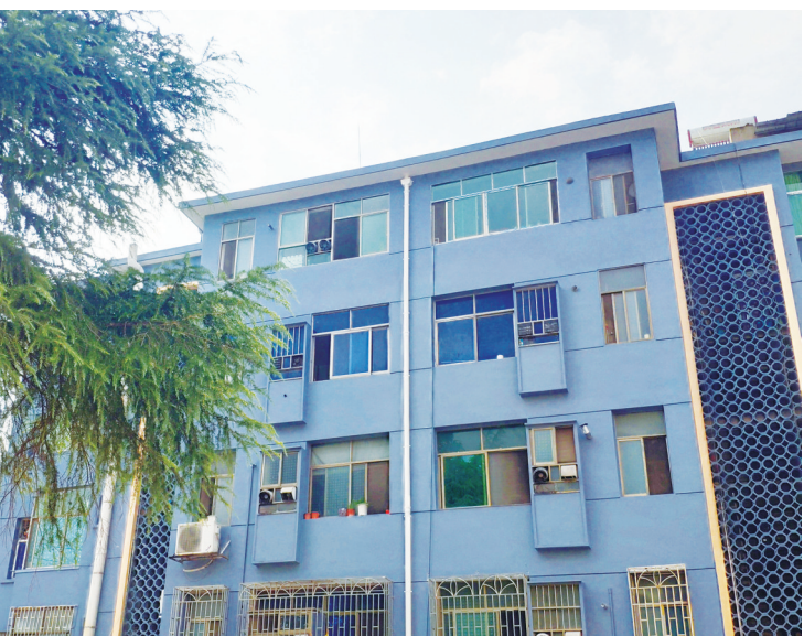
改造后焕然一新的林化厂家属区房屋立面。
