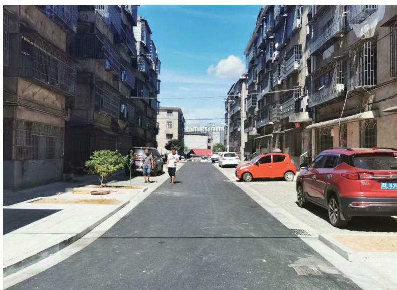
经过改造,林化厂家属区内破损的水泥路变成了平坦宽阔的沥青道路。
