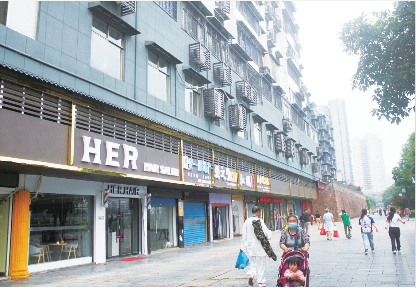
市区资江南路老旧小区改造是邵阳市重点工程项目,东起沿江桥市政府西、西至西湖桥东的临江建筑物,涉及沿线20栋738户住房及门店的房屋综合改造,总投资941.6万元。经过大祥区住建局3个月的集中施工,已于5月20日基本完工。图为改造后的资江南路沿街建筑物街景。
