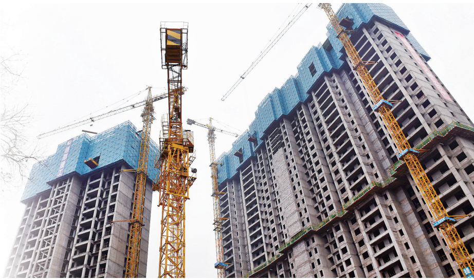
六岭公园恢复性建设及周边棚户区改造项目位于市区红旗路与邵水西路交汇的邵府街、田家湾地段,是提升城市品位、改善人居环境的重点民生项目。图为建设中的六岭棚改项目。
