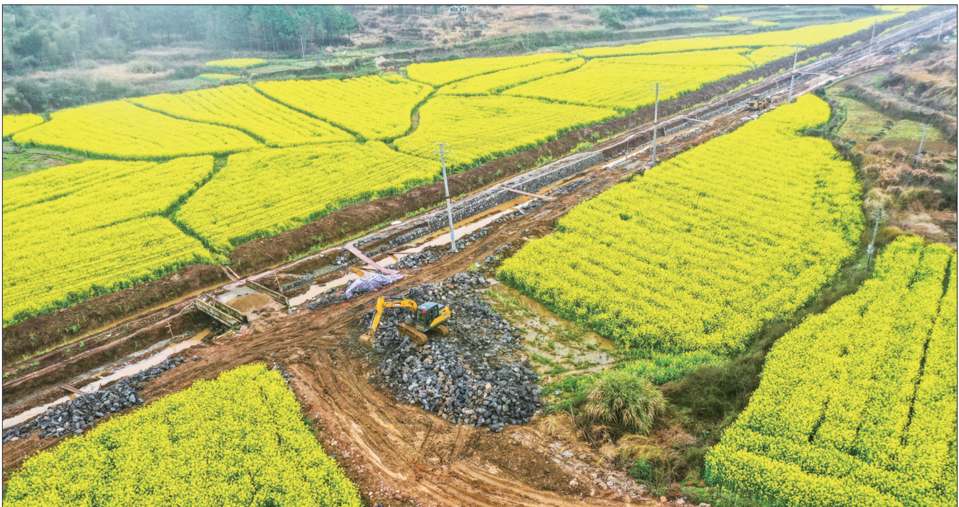
3月7日,施工人员正在邵阳市魏家桥镇霞光村对该村1800余米河道加紧进行整修,同时修建机耕道。工程预计5月份完成施工。邵阳日报记者 申兴刚 摄
