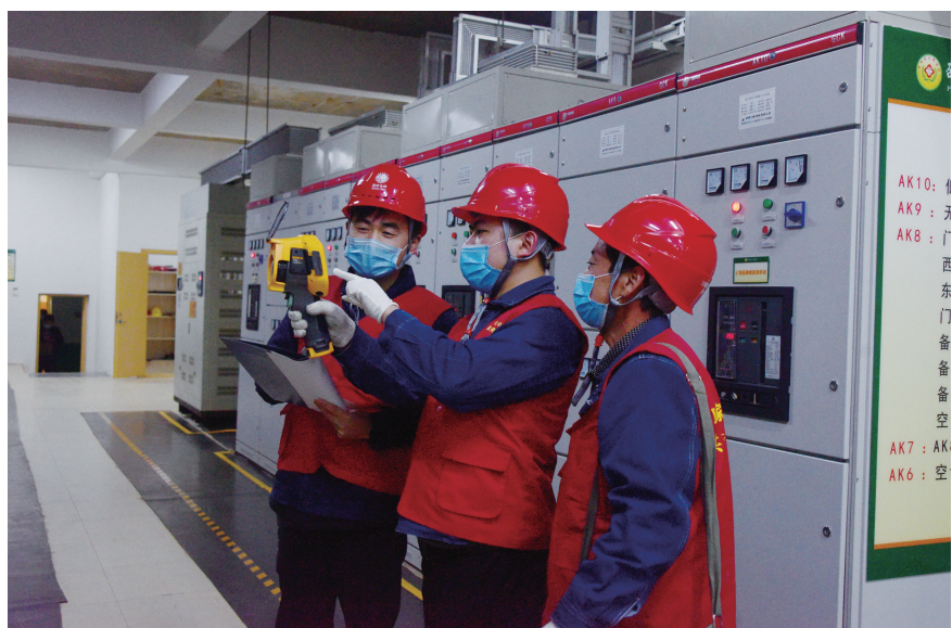
陈柯宇、李诗瀚、李易潘在邵阳县人民医院地下配电室进行安全检查。
