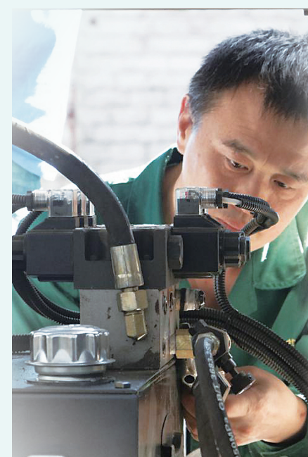
工作人员在安装调试钢筋桁架自动折弯生产设备。
