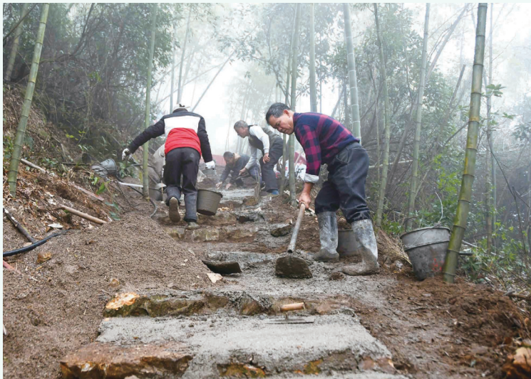
村民们正在修建通往山顶的游步道。
