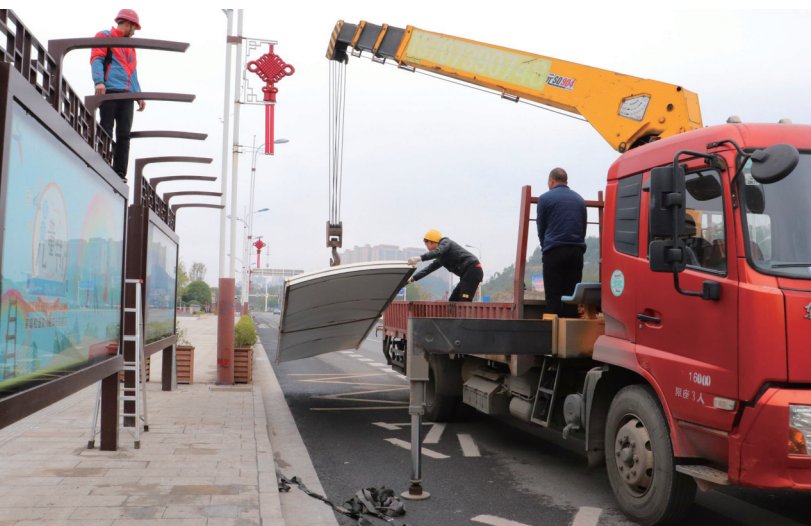
施工人员安装公交候车亭遮雨棚。
