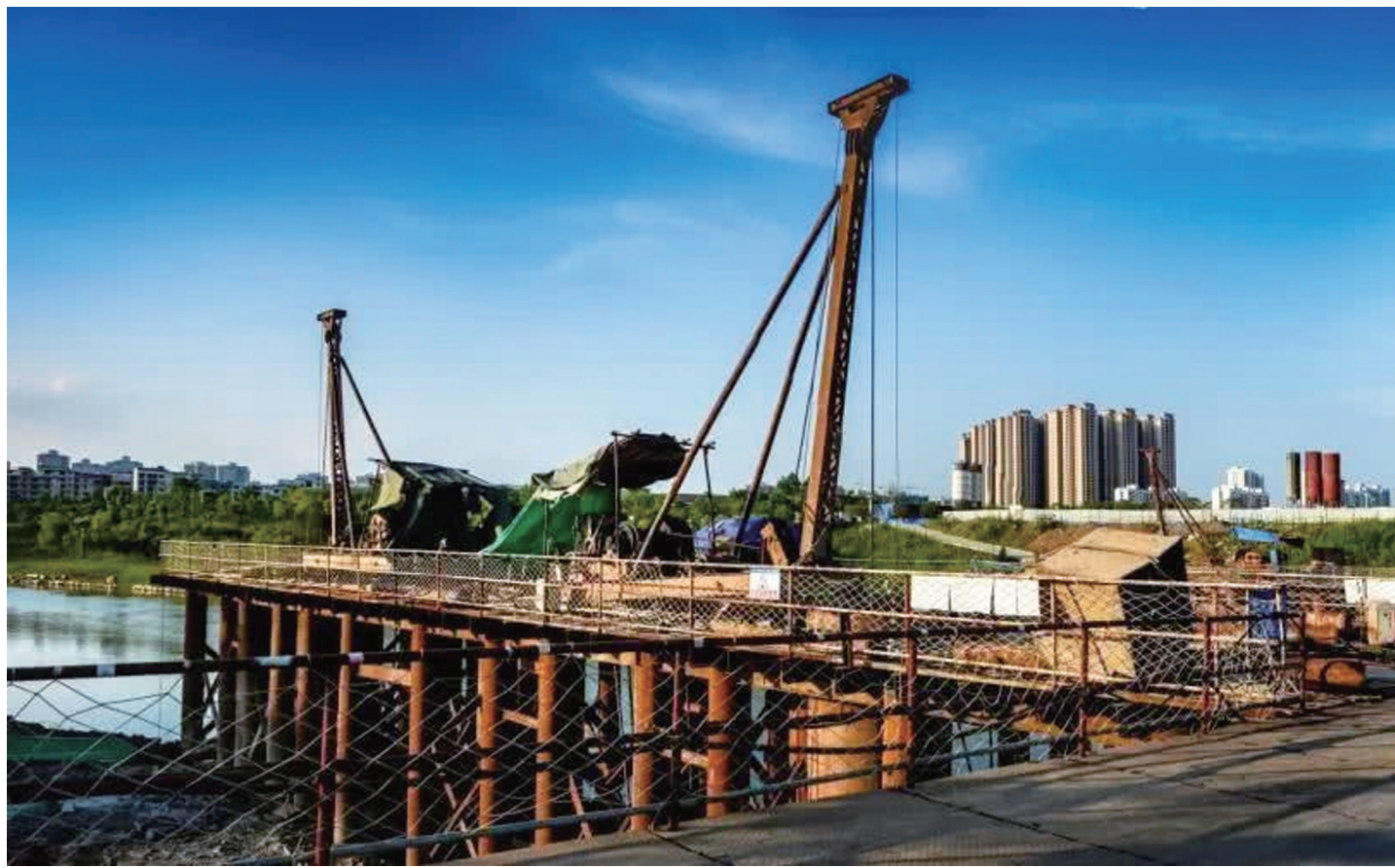
桃花桥桥墩基础层正在日渐向前延伸。
