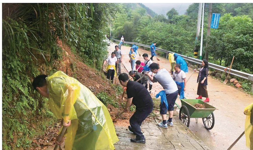
抢险队员正在塌方路段清除泥渣。
