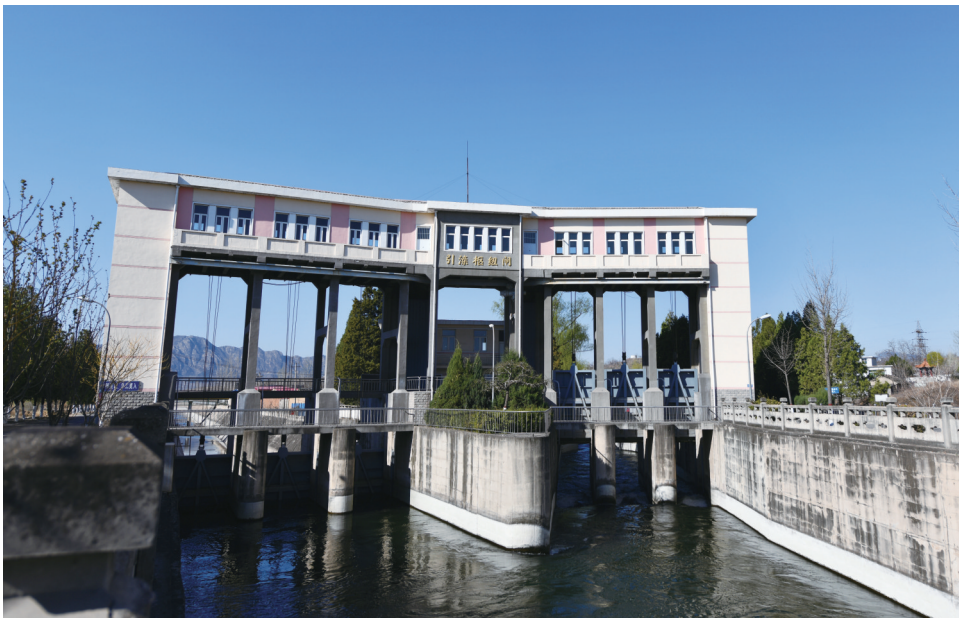
这是4月10日在河北省迁西县拍摄的引滦枢纽。新华社记者李然摄
