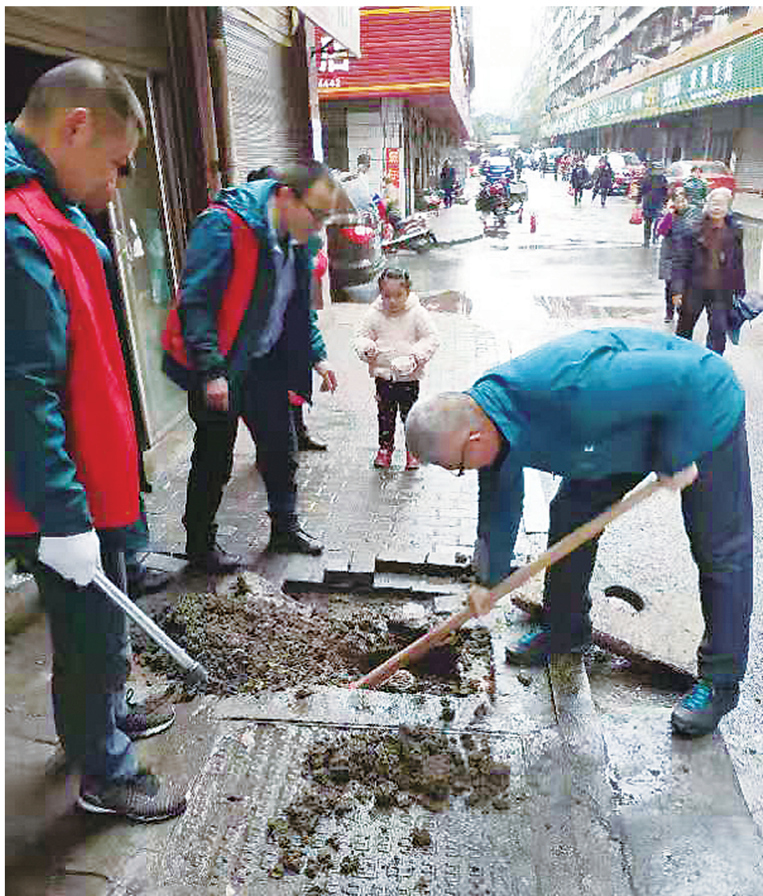
维修人员找到水管爆裂点,进行维修。
