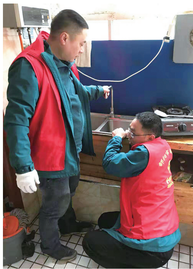
给居民修理水管。
