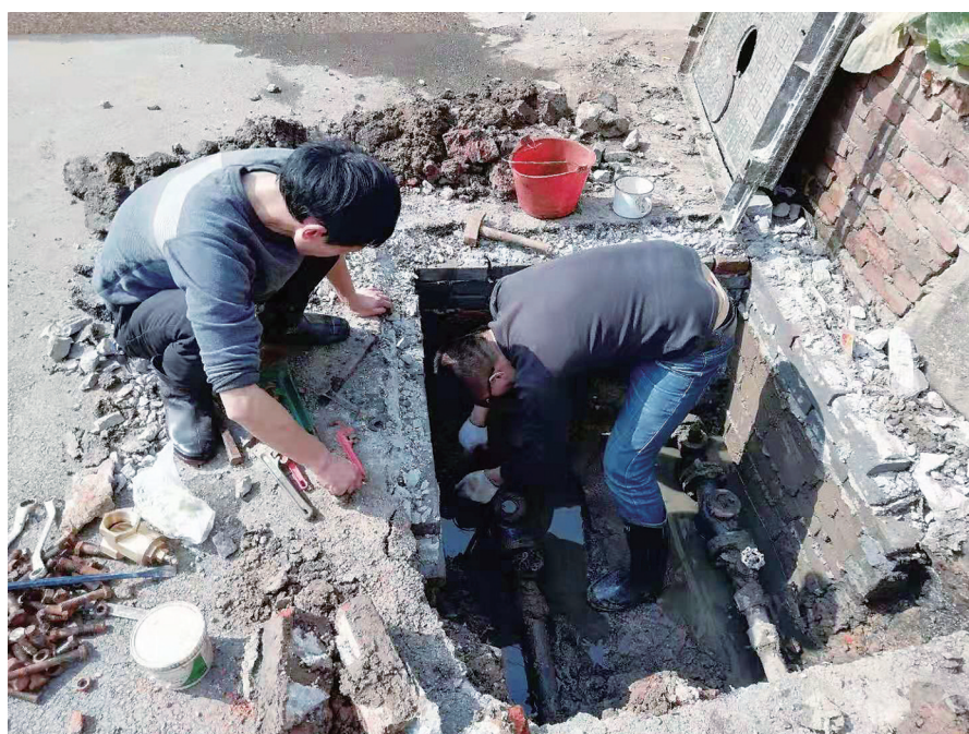
修理爆裂的水管。
