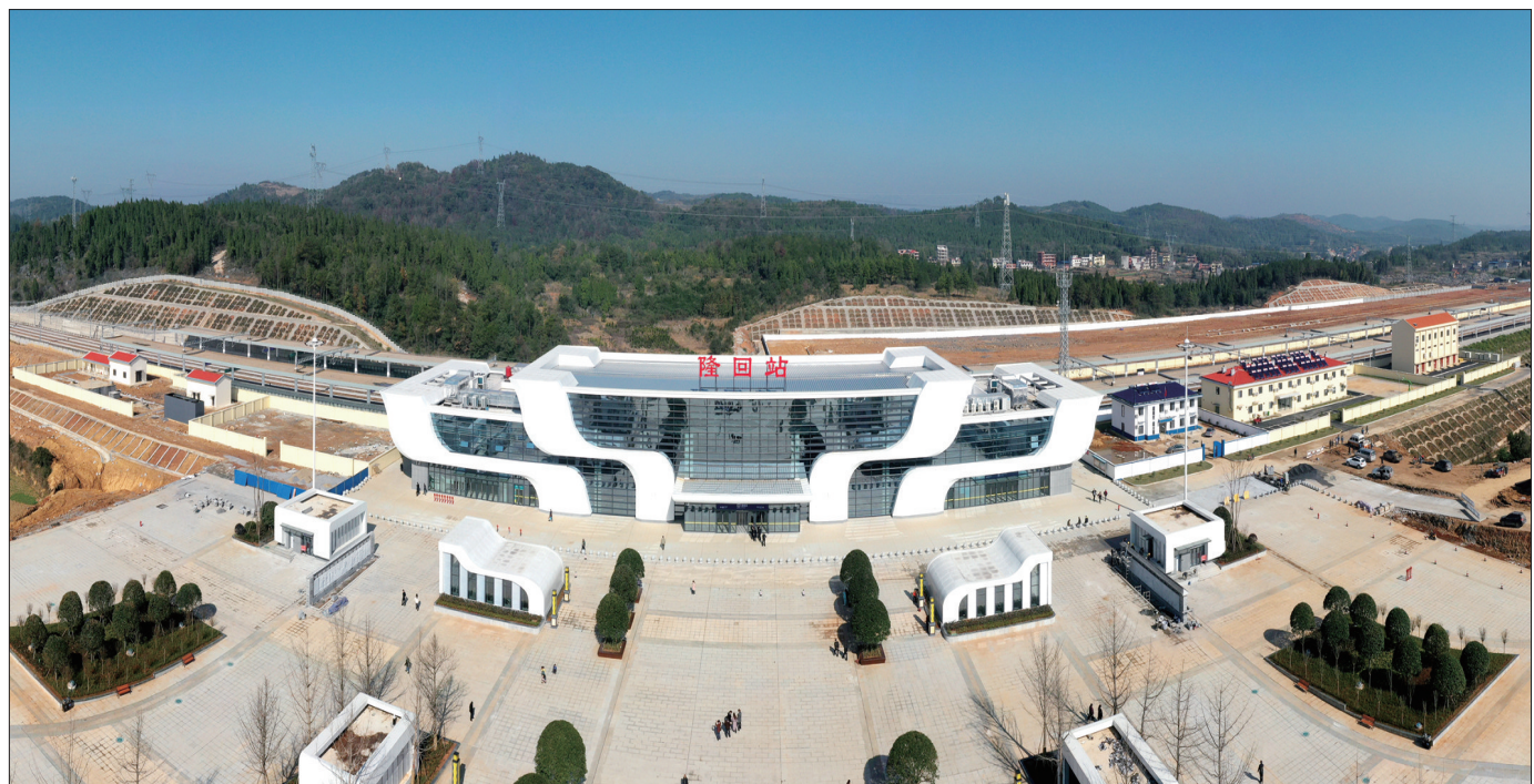
隆回火车站是怀邵衡铁路站点之一,位于隆回县城北侧大花村,距离县城3.5公里。目前该站主体工程、站前广场及地下车库、绿化均已经完成施工,站前雕塑正在加紧施工,本月20日前,站前魏源大道将完成双幅通车,隆回大道将完成单幅通车。图为12月18日,站前广场及绿化已经全部完成的怀邵衡隆回火车站。
