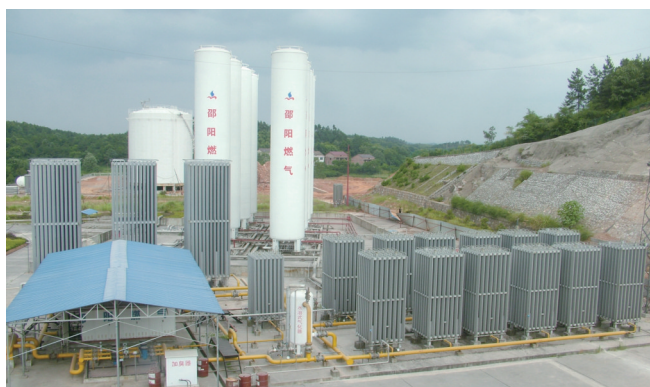
市燃气总公司江北气站。管输天然气入邵后,它发挥应急调峰作用。(市公用事业局供图)
