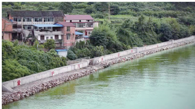
目前,我市市区截污管网已超过130公里。图为江北污水处理厂配套管网一角。邵阳日报记者 罗哲明 摄
