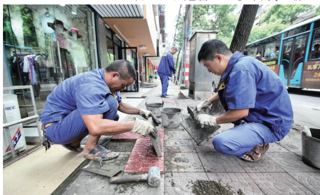
市政公司施工人员在大祥区域北路修补人行道彩砖。邵阳日报记者 罗哲明 摄
