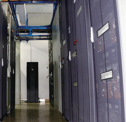
邵阳电信江北传输机房一角。 沈璐 摄
