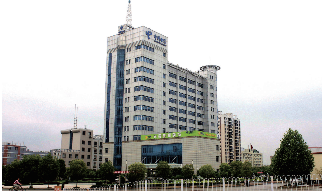
2007年,邵阳电信江北办公大楼落成,标志我市电信事业进入飞速发展阶段。 沈璐 摄
