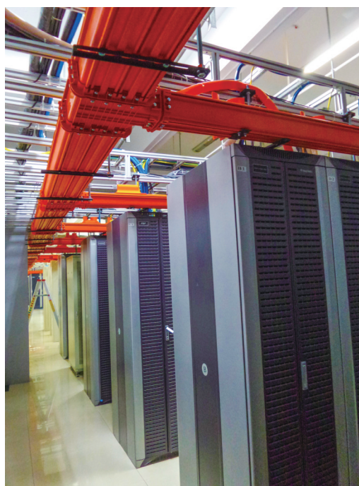
邵阳移动公司机房
