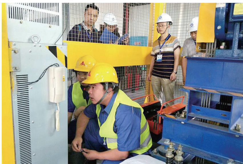
电梯维修工正在进行实际操作(电梯故障维修)竞赛。
