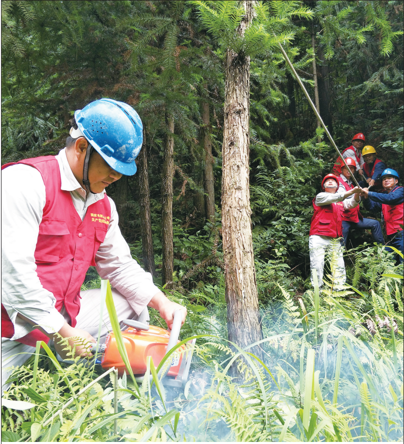
6月3日,国网隆回县供电公司组织党员服务队对司门前镇10千伏司锌线开展线路特巡,着力清理电力线路通道内的违章树木、违章建筑物等,确保电力线路走廊安全畅通。
