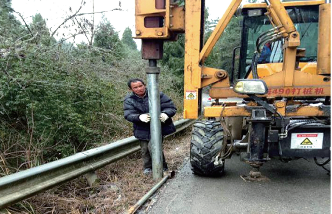
▲今年1月,受冰雪影响,洞山醪公路K132+709处钢护栏损毁60余米。图为打桩机正在打桩。
