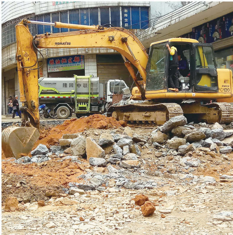
5月6日,隆回县司门前镇城区道路改造升级工程正在紧张施工。为打造魏源故里历史文化特色小镇,该镇投入资金对城区主干道进行升级改造,改造工程包括铺设草砂路面、弱电入地、路灯亮化等。 贺上升 摄
