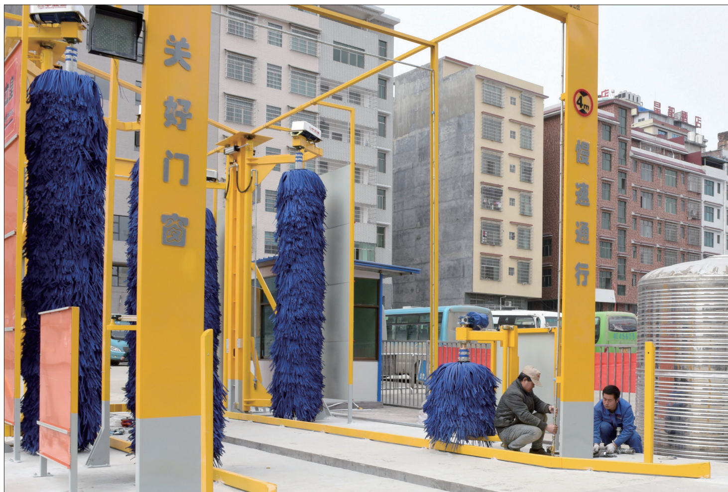
为备战春运高峰,确保春运平安有序,近日,邵阳湘运集团斥资200余万元为洞口汽车总站安装三品检查仪和自动洗车机等机械设备,新建客运车汽修厂并投入使用。图为2月2日,施工人员在本站安装自动洗车设备。
