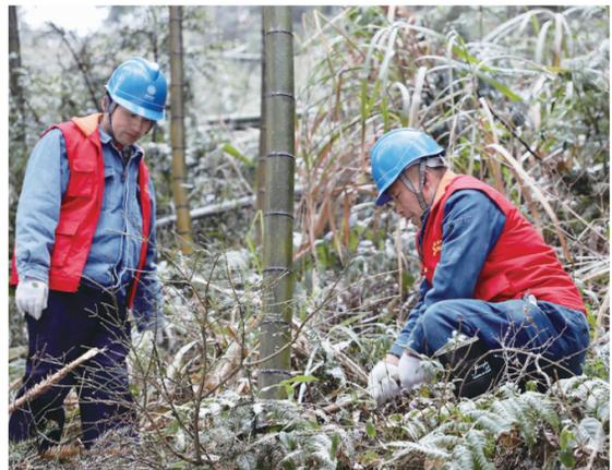
1月26日,国网新邵县供电公司对接区内的高负荷线路进行交叉跨越测量,对线路廊道内施工点、线路树障点、覆冰区及耐张杆塔各联接金具等进行大排查,及时处置所发现的问题。图为工作人员在潭府乡境内对线路树障点进行清理。
