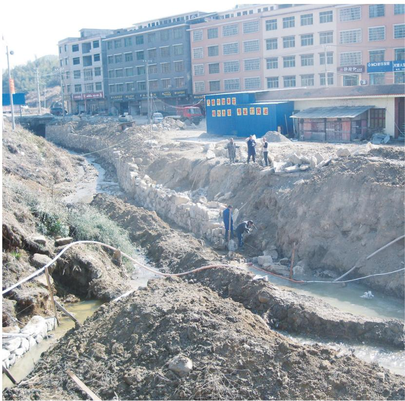
隆回县小沙江镇湘运汽车站背后的一处水毁河堤工地,民工们正在紧张地施工。此处河道长1000余米,两岸河堤严重受损,有几处还出现垮塌现象,给两岸300余户居民的房屋安全造成严重隐患。入冬以来,该镇党委政府争取国家投入资金,筑两道基脚深1.5米、高3米能抵御洪涝灾害侵袭的“铜墙铁壁”。
