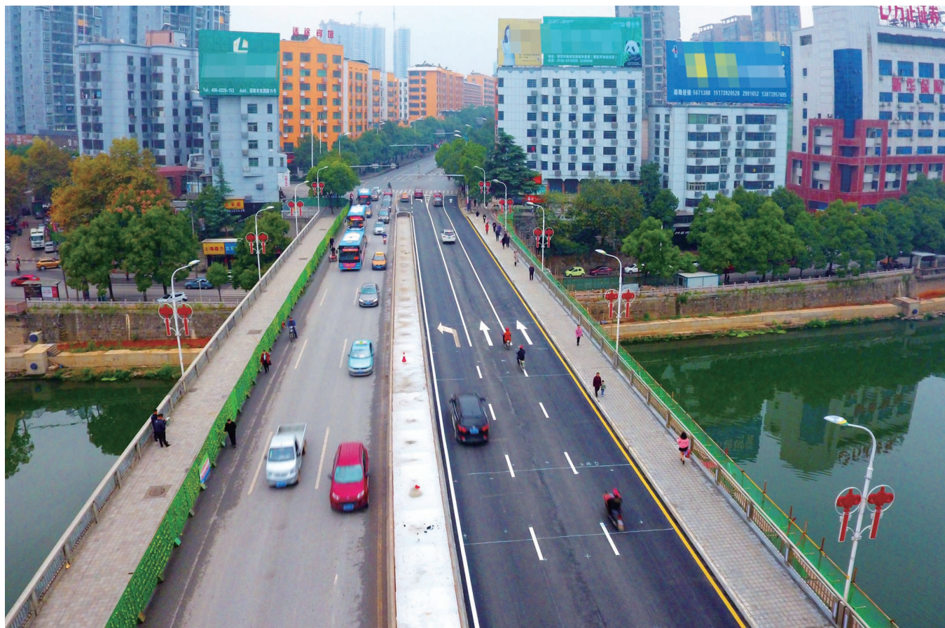
图为加固改造后的邵水桥 申兴刚 摄
