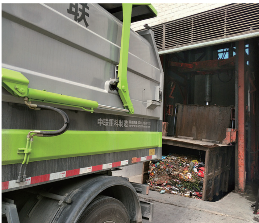
全县一盘棋统一部署、统一设计、统一标准建设垃圾压缩站,新建和改建乡镇垃圾中转站17座。图为建好后投入使用的六都寨垃圾中转站。
