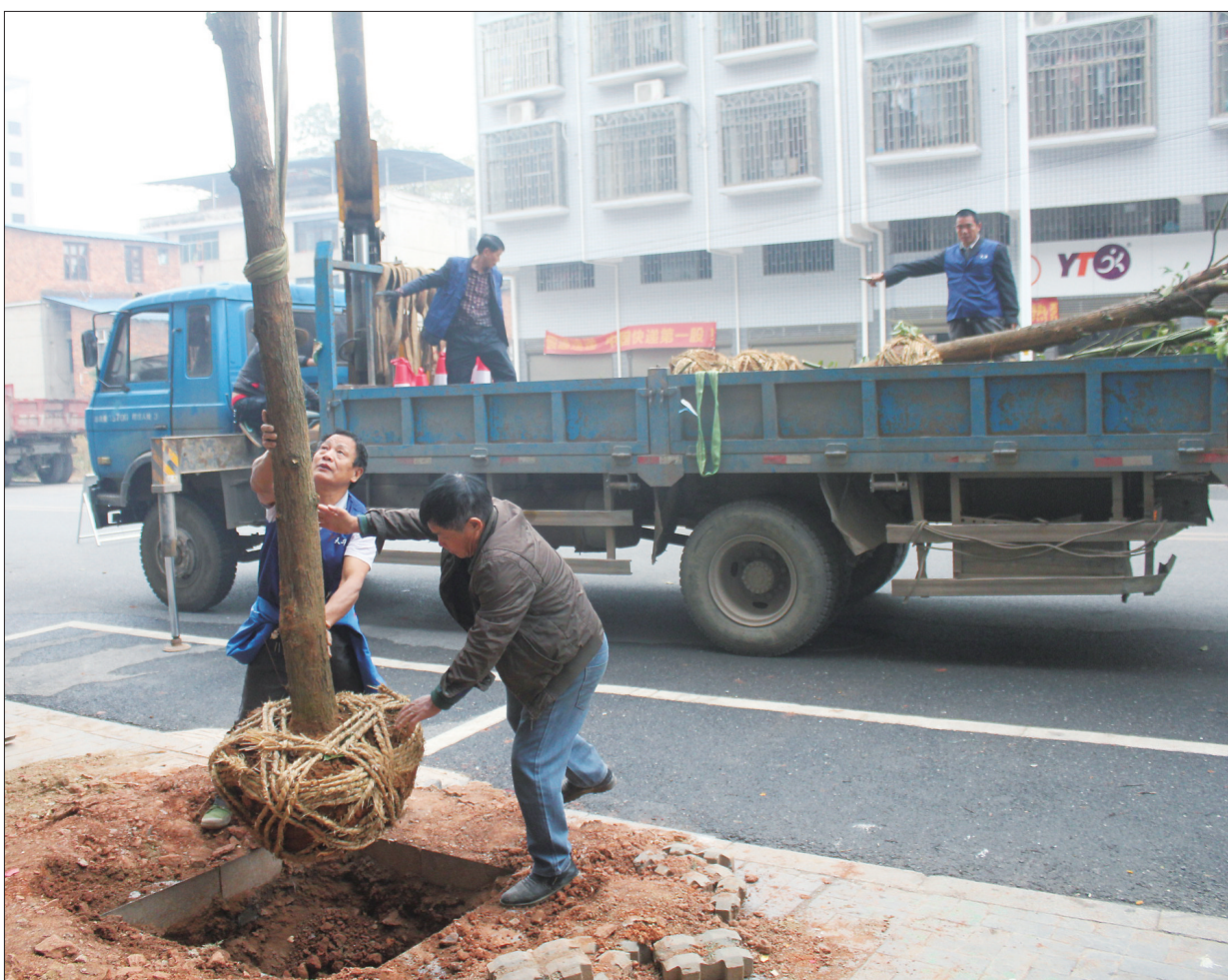
入冬,我市树木进城增绿行动加速。截至目前全市共打桩3700多个,栽种树木2500余株,预计到12月底前3万株绿化树将全部栽植到位。图为11月7日,园林工人在市区迎春路沿线栽植绿化树。 伍洁 摄
