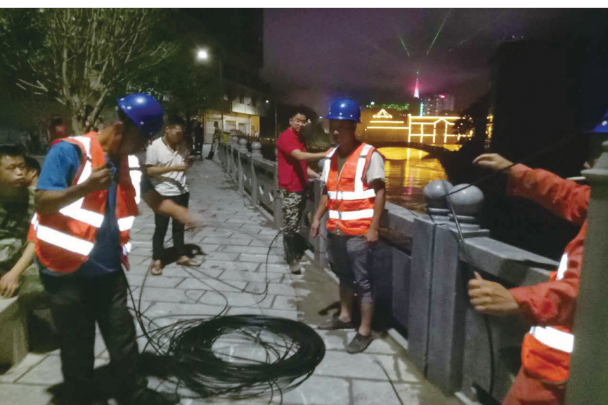
邵阳联通连夜放临时光缆抢通干线
