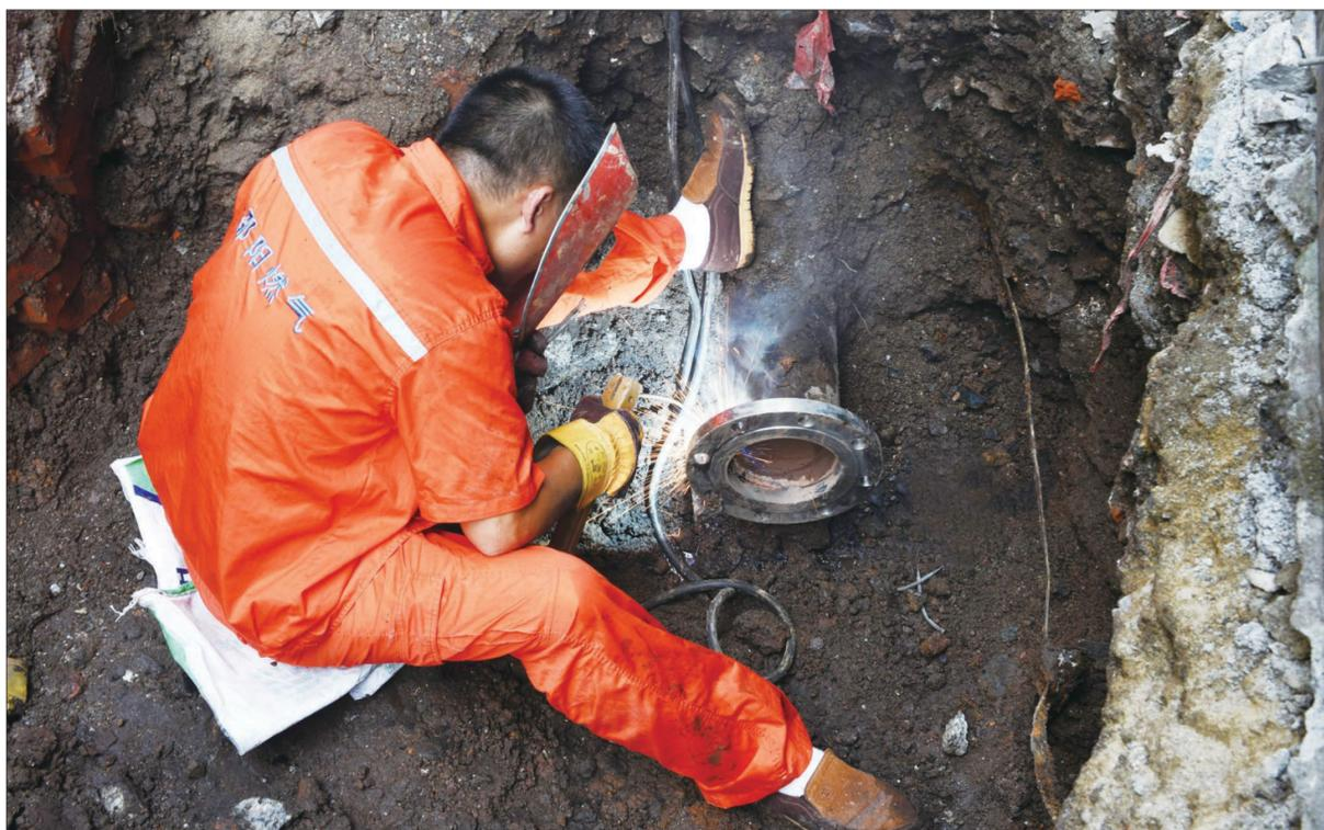
8月3日上午9时,市燃气总公司巡线人员在市区曹婆井路段安全巡查时发现燃气低压干管发生锈蚀穿孔,该公司立即组织十余名抢险队员进行抢险抢修,在上午11时左右就消除了安全隐患。图为抢险队员正在焊接燃气管道。
