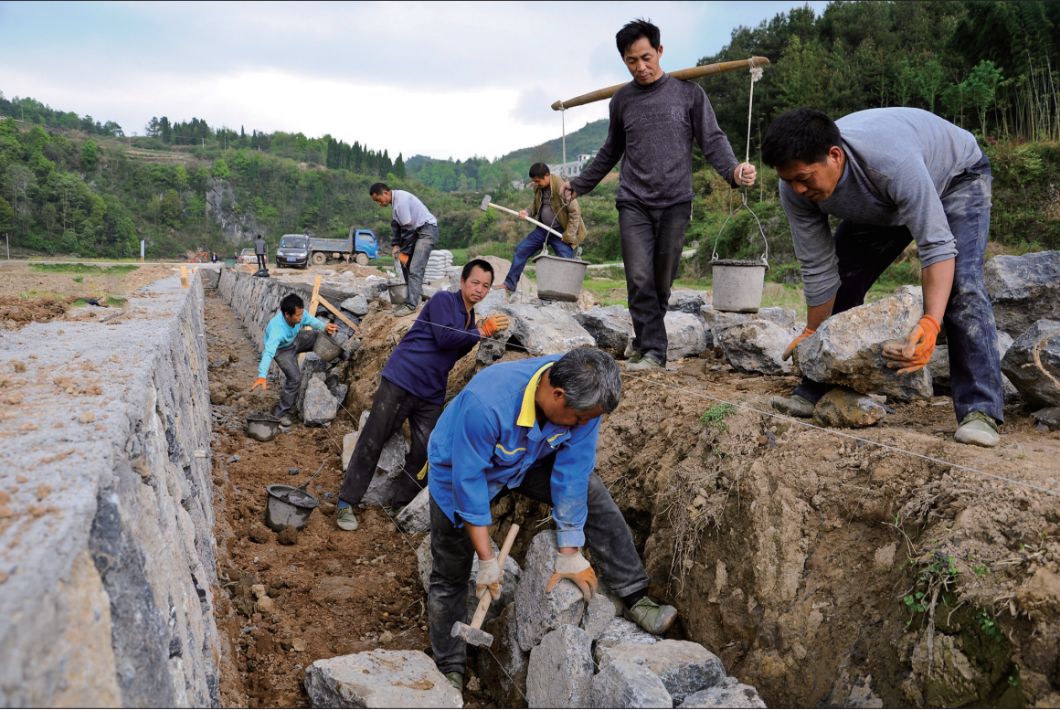
4月6日,水利施工人员正在新宁县巡田乡长铺村田间砌筑水渠。近年,该县农业综合开发如火如荼,全县16个乡镇的农田水利灌溉得到了极大的改善。当前,总投资为1568万元的巡田乡桐古高标准农田水渠建设项目正在加紧建设之中,项目整体建设已完成65%,预计工程今年5月底全面完工,可灌溉水田9600亩。 郑国华 周光宏 摄影报道
