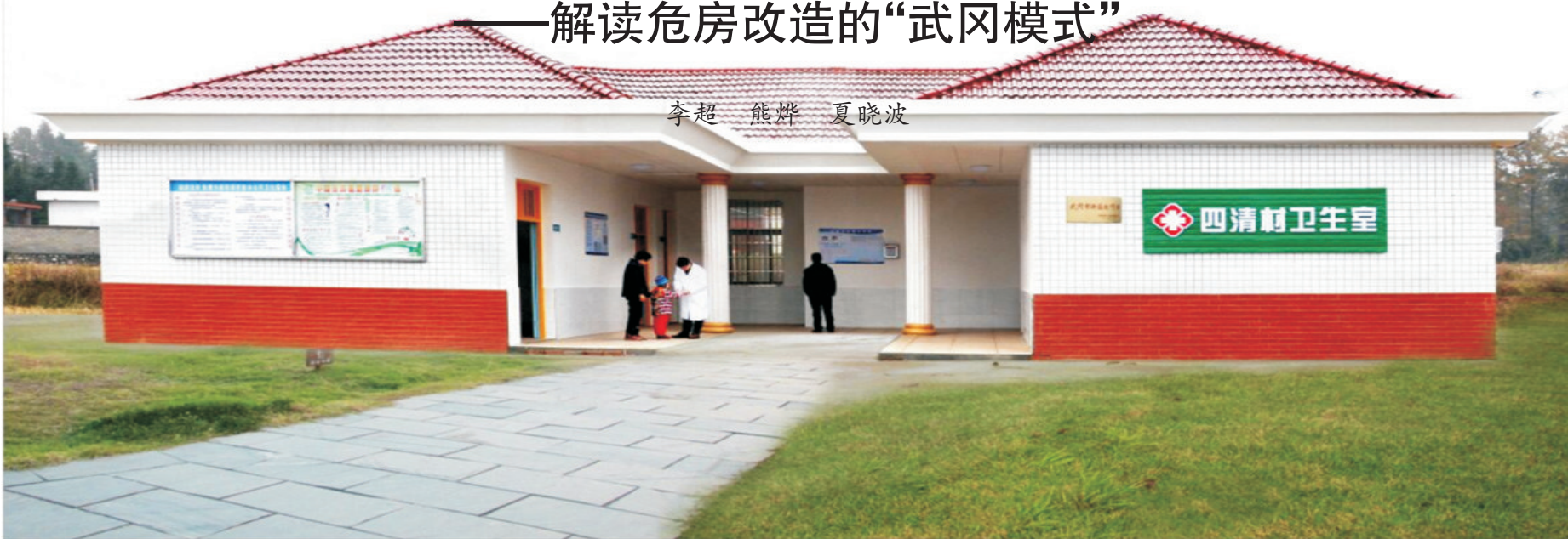
新建成的湾头桥镇四清村卫生室。
