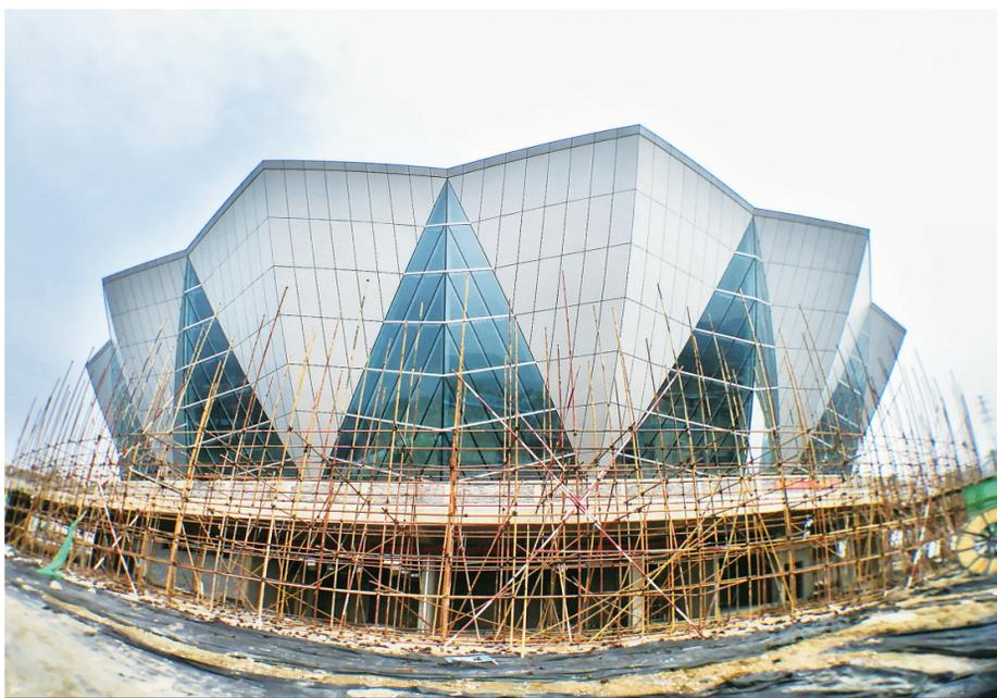
1月4日,市体育中心项目体育馆外貌露出玻璃幕墙“真容”。该项目占地1700余亩,集体育中心与体育公园于一体。目前,体育场完成三层看台;体育馆玻璃幕墙完成60%,内装地板铺设完成40%;游泳及综合训练馆土建工程已完成钻孔300余个,其它配套工程正在加紧建设中。
