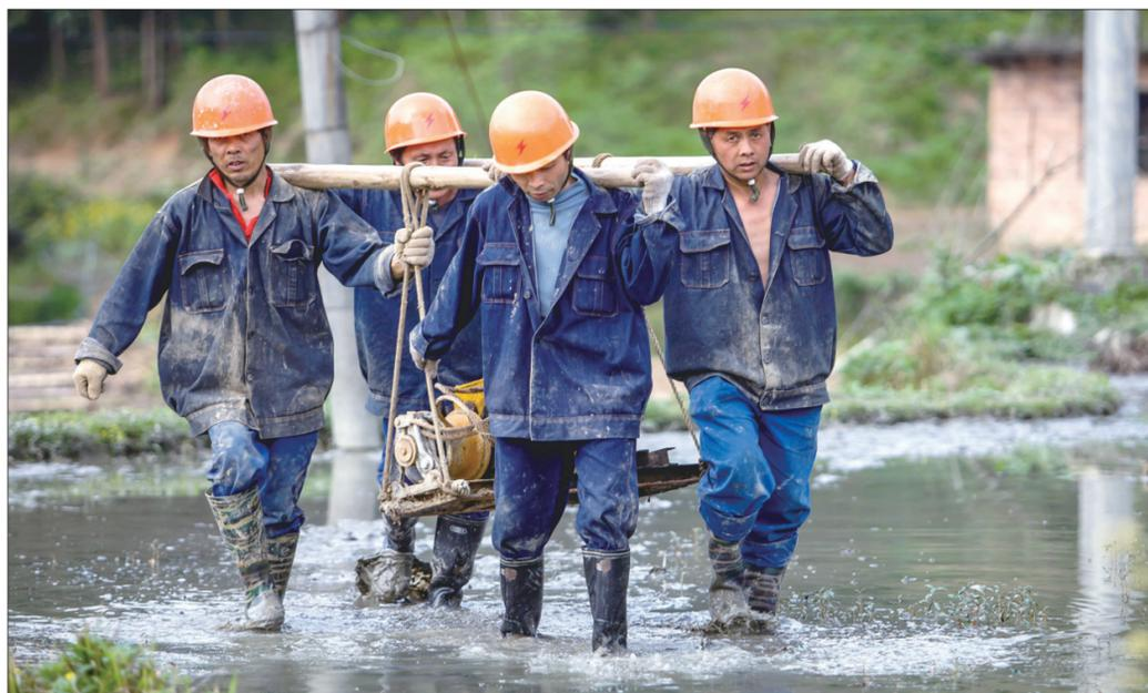
“施工队进村了，花山有希望了！”5月8日，新邵县寸石镇花山村农网改造工地上一片忙碌。根据项目计划，电力部门将在花山村新建10千伏线路2.02千米，新建220-380千伏线路6.628千米，新建配变区5个，利旧移位配变改造台区1个，新增低压综合配电箱6台，对147户村民进行“一户一表”改造。
